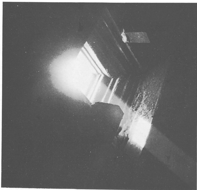
b) Utrot: Moschea. Vano di apertura ricavato nella copertura dell'ambiente chiuso per lo sfogo del fumo del focolare (F. B. 1968)
